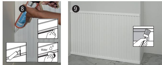
**Install the CX190 as a top rail\*** | Installeer de CX190 als afwerkingsrand\* | Installez la CX190 comme bord de finition\* | Installieren Sie die CX190 als Oberschiene\* | Instale la CX190 en la parte superior\* | Установите CX190 в качестве верхней направляющей\*
