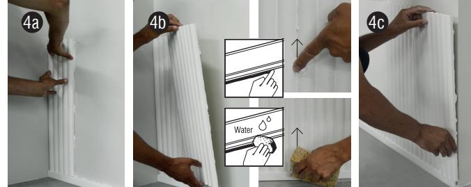
**Install CX190 as skirting board\*** | Installeer de CX190 als plint | Installez la CX190 comme plinthe\* | Installieren Sie die CX190 als Sockelleiste\* | Instale la CX190 como rodapié\* | Установите CX190 в качестве плинтуса\*
